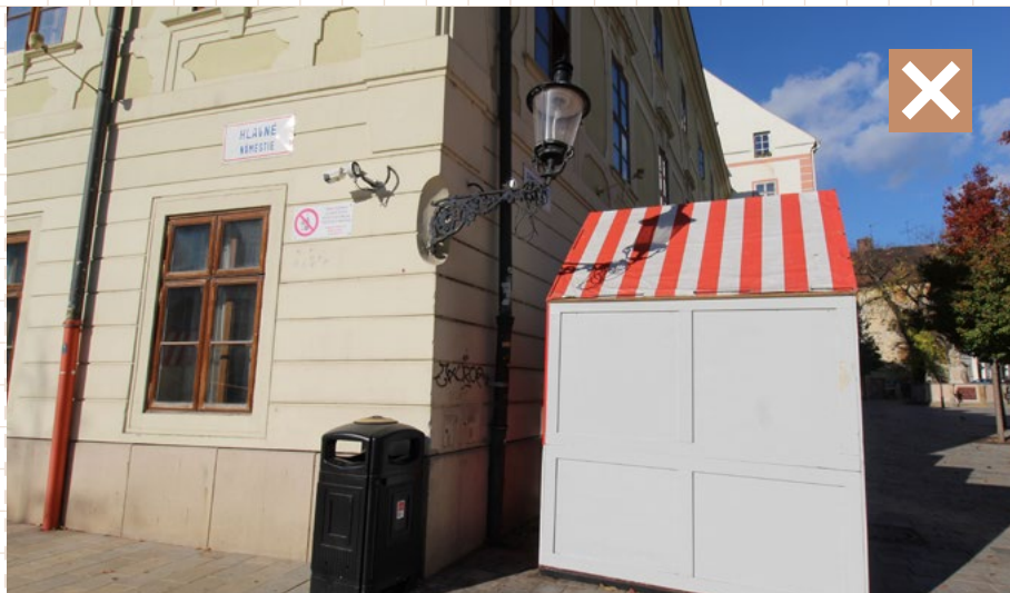
27 Konzola VO je umiestnená veľmi nízko, čím môže dôjsť k jej poškodeniu vozidlami zásobovania, prípadne vozidlami údržby. Bratislava, Hlavné námestie
